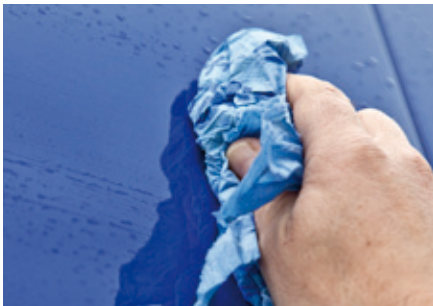
01 Untergrund reinigen z. B. mit Isopropanol
